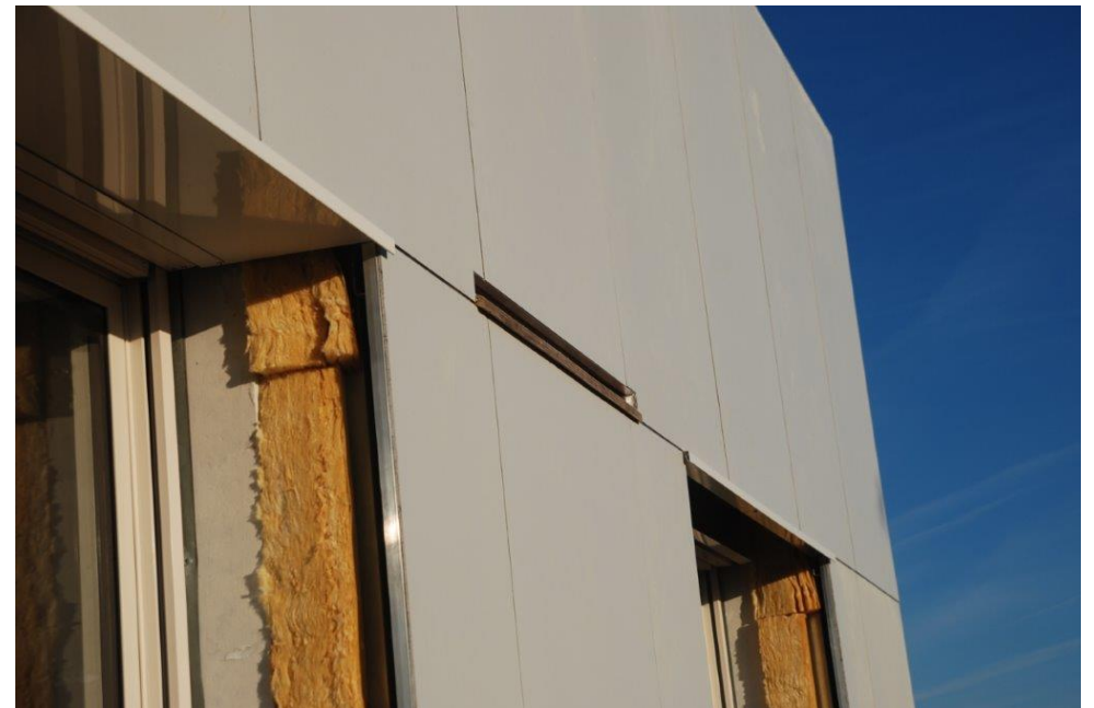
Photographie après la pose de l'isolant et le retrait des tasseaux
