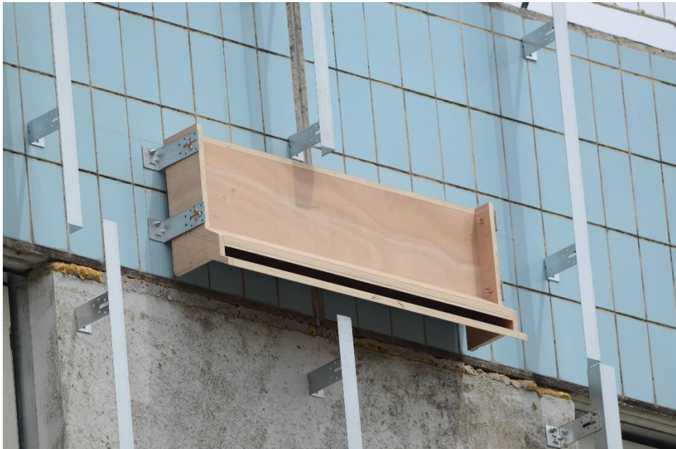
Photographie après la pose de l'isolant et le retrait des tasseaux
