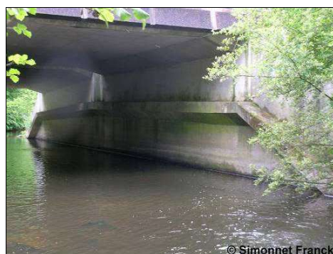
Exemples de passages à Loutre aménagés en Bretagne : buse sèche (h.g.), banquette en bois (h.d.), banquettes en béton (b.g.) et banquette en encorbellement (b.d.)
