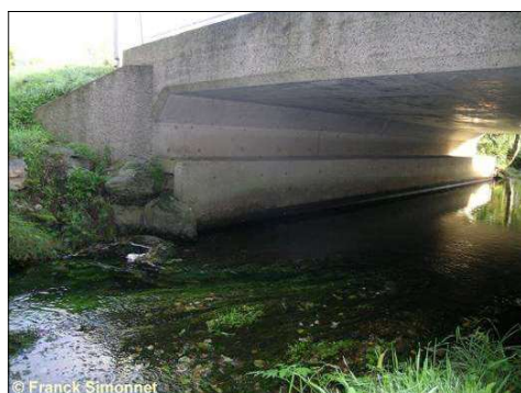
Exemples de passages à Loutre aménagés en Bretagne : buse sèche (h.g.), banquette en bois (h.d.), banquettes en béton (b.g.) et banquette en encorbellement (b.d.)
