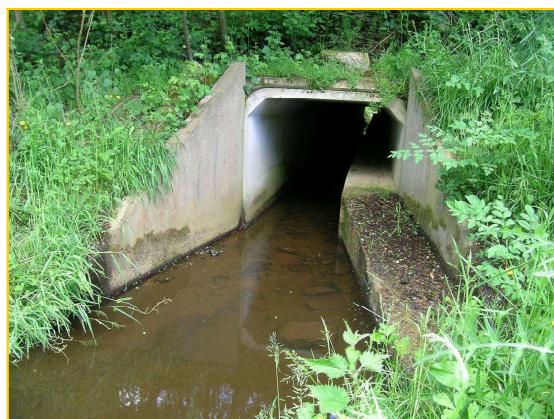
Passage à Loutre de type « banquette béton simple » aménagé sous la N165 dans le Morbihan
