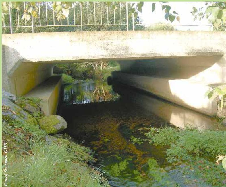
Les passages à loutre, en assurant un cheminement « terrestre » sous les ponts, permettent de diminuer le risque de collision routière.
