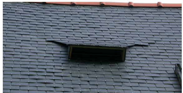
Création d'une chiroptière pour la sauvegarde d'une colonie de Petits rhinolophes de l'ouest des Côtes d'Armor. J. BOIREAU
