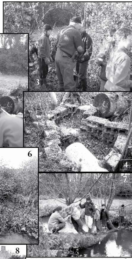
Construction de «catiches» au Moulin-Roland
