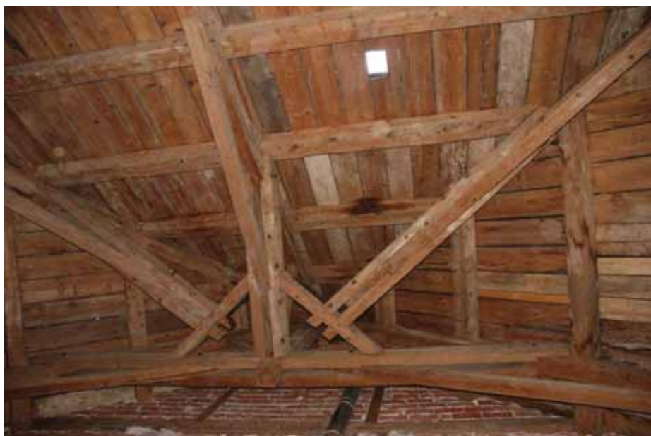
Toiture vue depuis le plancher au 1 er étage de la grange
