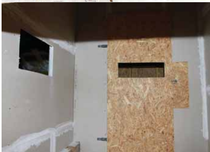
Porte d'accès aux combles vue depuis la chiroptière
