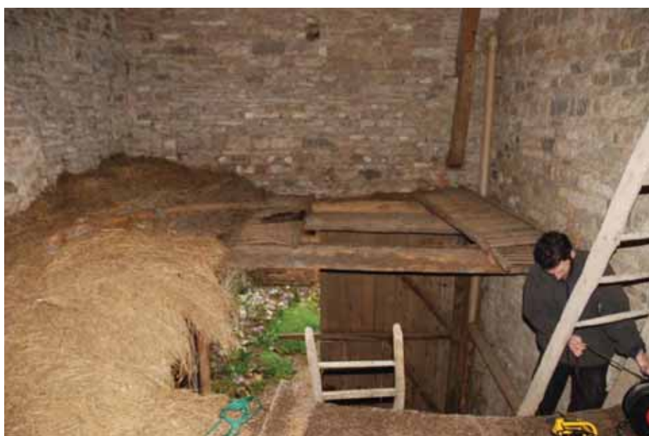
Vue depuis le plancher au 1 er étage
