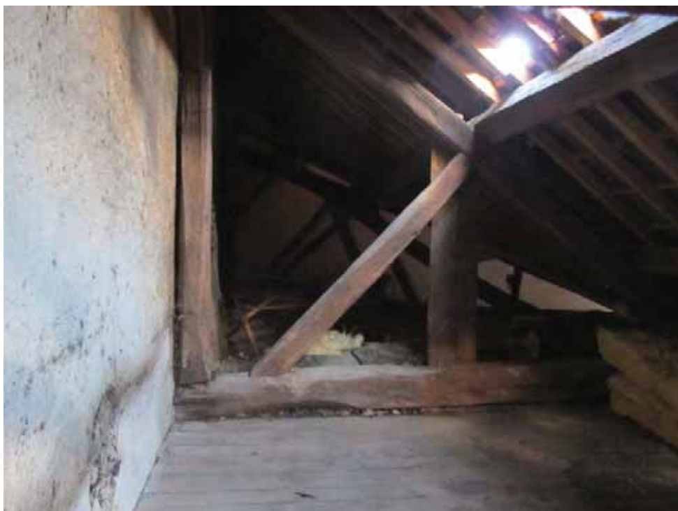
Aménagement de la cloison
