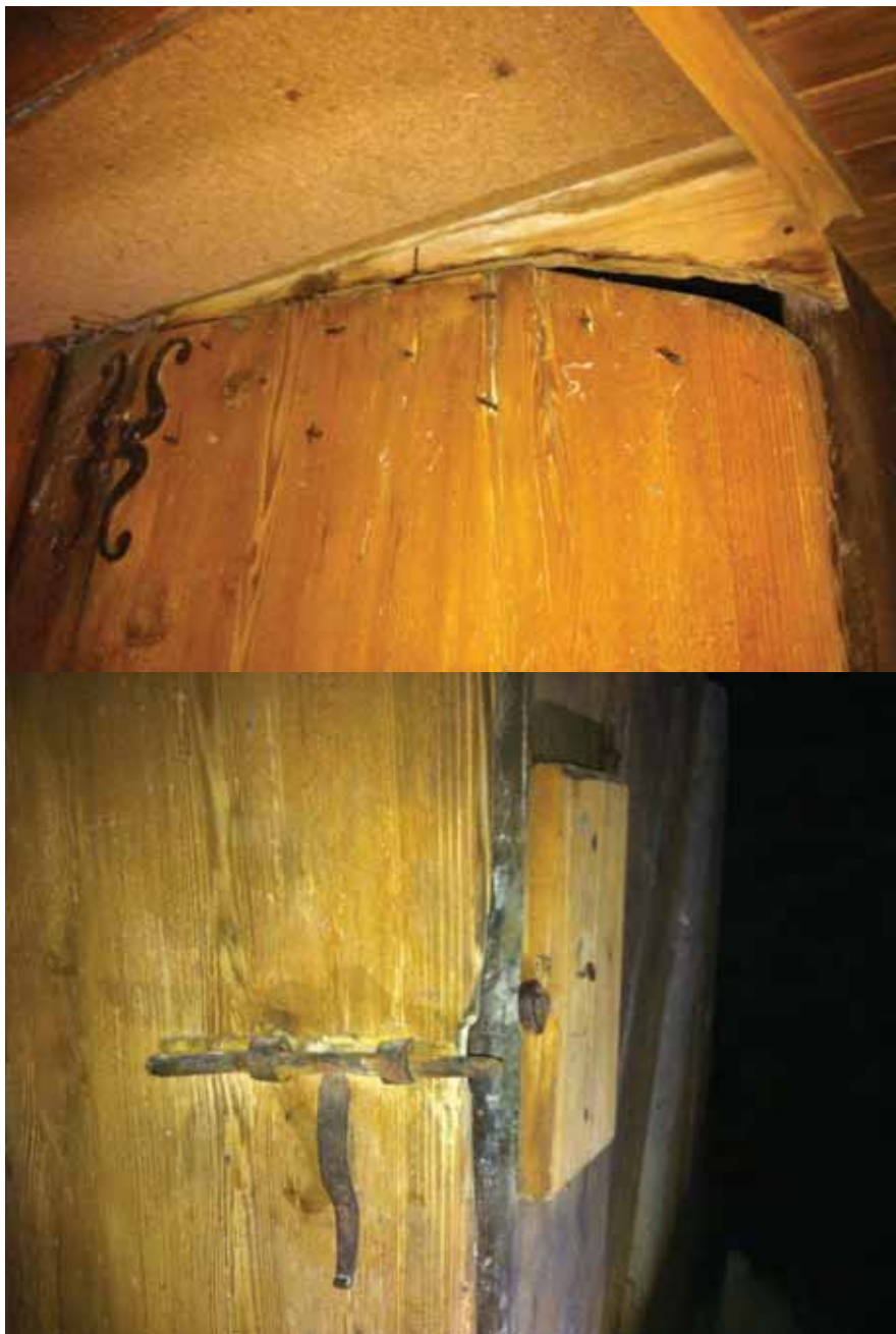
Découpe de la porte et reprise du système de fermeture
