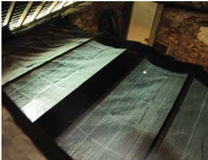
Bâche au-dessous pour récupération de guano
