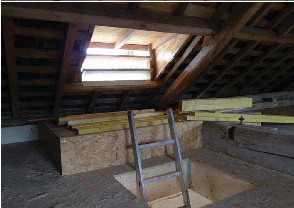
Chiroptère vue de l'intérieur avant installation du sas
