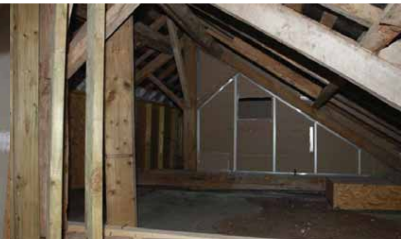
Sas vu depuis les combles
