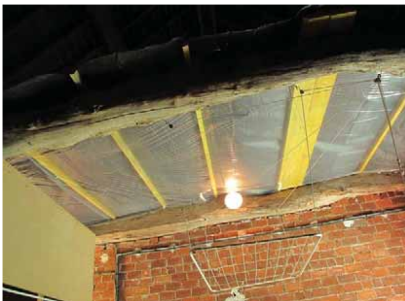
Pose de l'ossature
