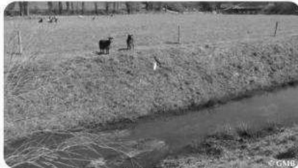
13 Entretien trop sévère de la végétation
