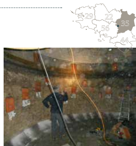
Briques plâtrières installées à l'intérieur de la cuve du réservoir
