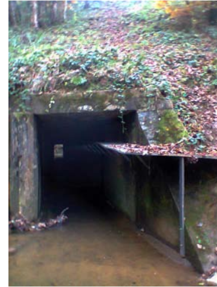
Nouvelle passerelle installée au croisement du Ninian et de la RN 164
