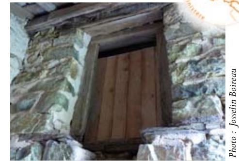
Porte avec accès pour les grands rhinolophes dans une maison forestière du Cranou.
