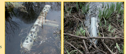
Trop-plein (busage de barrage «en T») dans les Monts d'Arrée : vu de l'amont (à gauche), et de l'aval (à droite).
