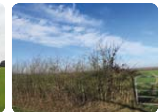
Haie basse fortement dégradée
