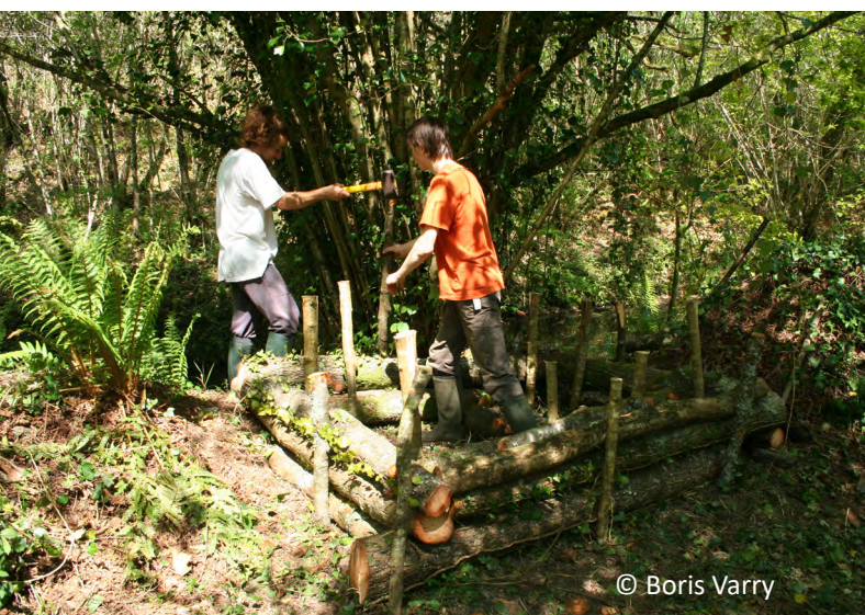
Chantiers de construction d'une catich en bois
