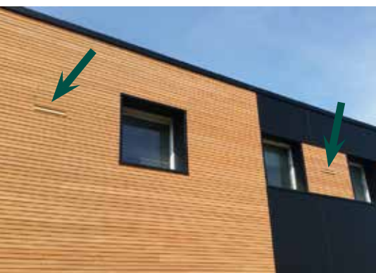
Les nichoirs, avant et après la pose de l'isolant et du bardage
