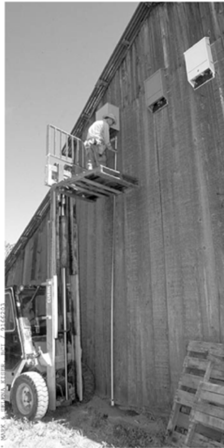
Les abris à chauves-souris montés sur des bâtiments, comme ceux-ci, en train d'être installés sur une grange californienne, donnent généralement de meilleurs résultats dans notre étude, en particulier dans les climats chauds et secs.
