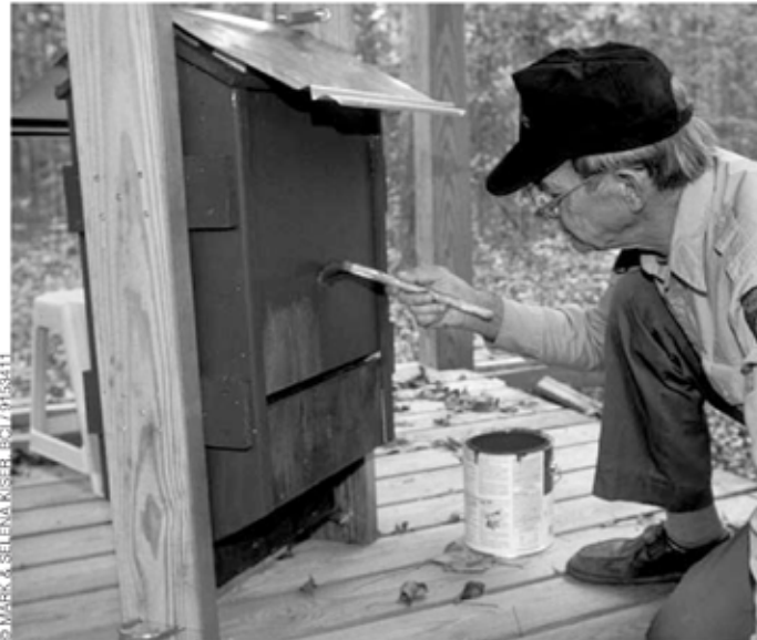
Ci-dessus : Peindre les abris allonge leur durée de vie et favorise des températures adaptées aux chauves-souris.
