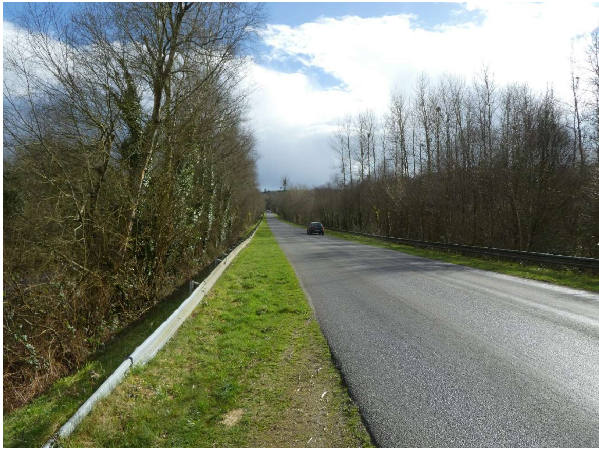
Remblais routier boisé en bordure de zone humide- Kercastellou- Langonnet (56)– 2025
