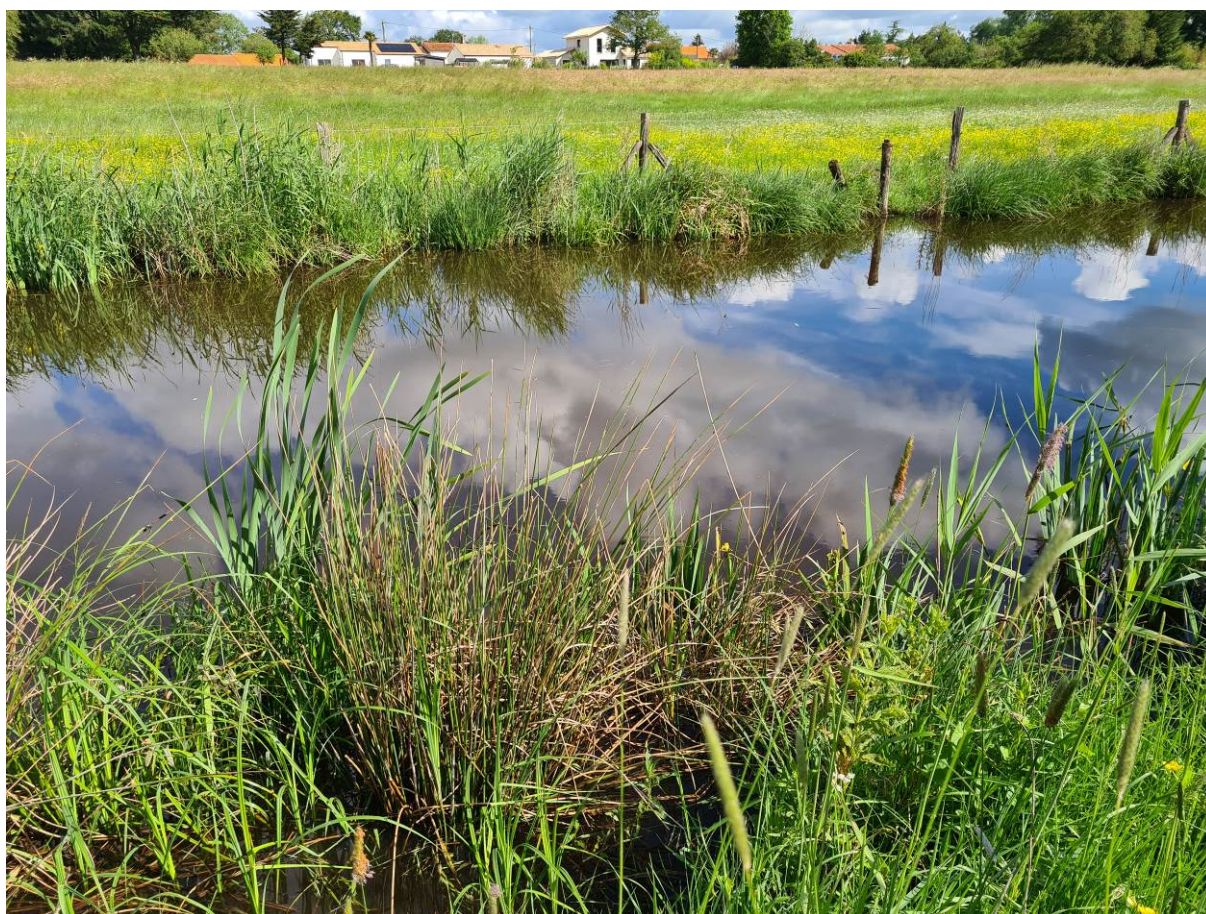
Le canal de Haute Perche Amont (44) 2 ans après les travaux
