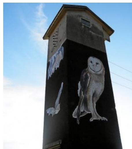
Exemple de transformateur aménagé pour la biodiversité « Mulipect » de Pleslin-Trivagou (35) Réalisation CCFIIR Emeraude
