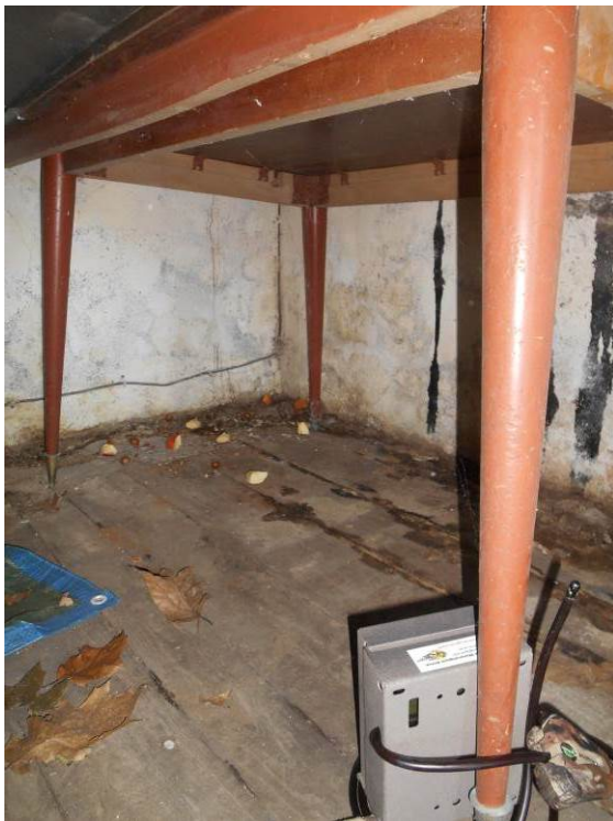
Dispositif de piégeage photographique en bâtiment sans mangeoire – Férel (56)
