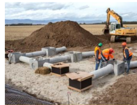
Mise en place des différents éléments du terrier, à l'aval du remblai engraissé - Photo SNCF
