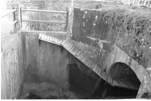
Figure 15: passerelle aménagée sous l'ouvrage de l'Oie
