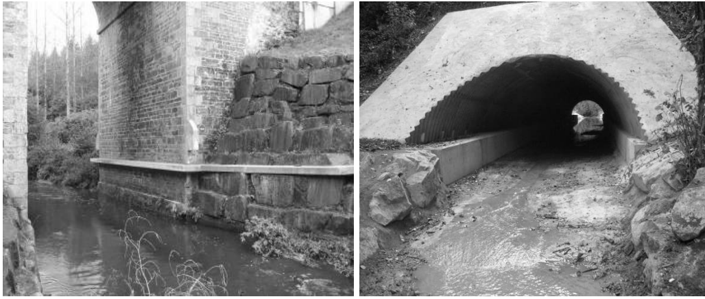
Figure 25: Exemples de réhabilitation d'ouvrages existants en Bretagne
