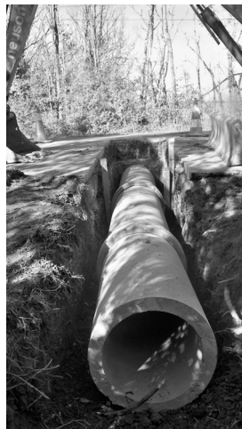
Figure 18: Terrassement et pose de la canalisation (diamètre 500 cm) en béton.
