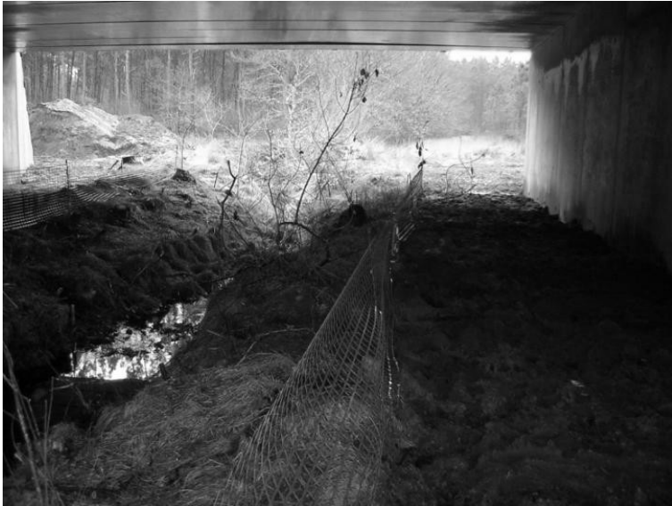
Figure 8: Même type d'ouvrage préservant le lit mineur (1 mètre de large) et les berges en fin de construction.
