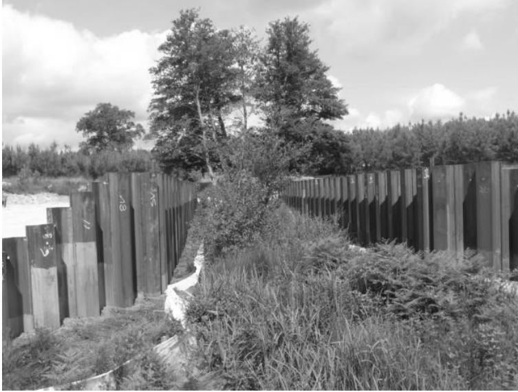
Figure 7: Début de construction d'un ouvrage préservant le lit mineur et les berges : là encore, la zone chantier est délimitée concrètement par une clôture amovible, afin d'éviter toute destruction ou l'altération du lit mineur et des berges naturelles bien végétalisées.
