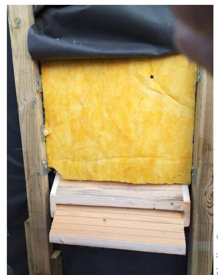
Nichoir à chauves-souris intégré dans l'isolation à Crozon avant recouvrement
