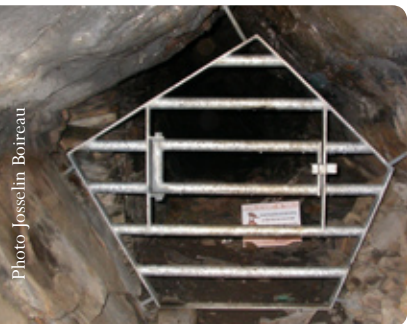
Grille de protection d'un gîte à chauves-souris
