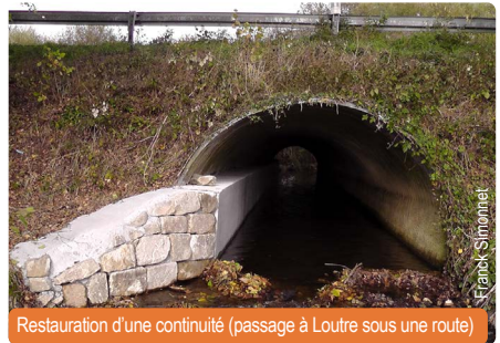
Restauration d'une continuité (passage à Loutre sous une route)
