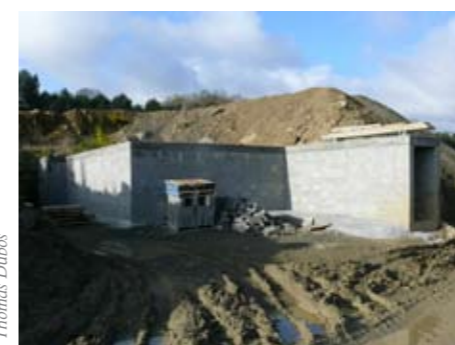
Tunnel pour les chauves-souris à Tréguieux (22) avant remblai.
