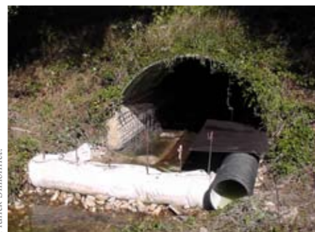
Passage à loutre en cours d'installation en Ria d'Étel (56)
