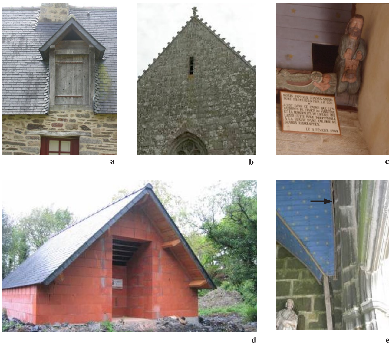
Fig. 1: (a): Abbaye de Saint Maurice (29), accès (environ 50 cm de large) des grands rhinolophes. (b) Eglise de Kernascléden (56), accès nord par lequel l'effraie des clochers pénétrait dans les combles. Accès bouché en 2002. (c): Eglise de Lopérec (29), accès unique de la colonie (environ 60 x 60 cm). (d): Bâtiment construit par le Groupe Mammalogique Breton dans le Finistère en 2006 pour permettre l'installation de grands rhinolophes avec une grille orientée à 45°. (e): Eglise du Faou (29): pour accéder aux combles, environ 60 des 100 grands rhinolophes installés en reproduction se glissent dans un espace de 8 cm de large entre le mur et le lambris (espace indiqué par une flèche sur l'image). Photos: Josselin Boireau.
