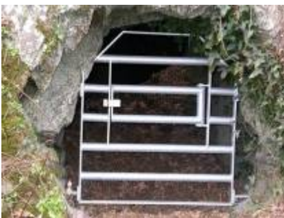
Pose de grilles à barreaux horizontaux pour protéger des gîtes d'hivernage pour les chauves-souris.
