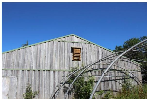
**Remarques** : Planches rainurées, moquette pour isoler la toiture en zinc du bois. Ensemble lourd (2 personnes pour le porter). Ce modèle est une version améliorée du modèle de base 4 chambres proposée dans le guide US : 5 chambres, variation des profondeurs des chambres.
