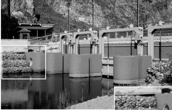
Barrage de Koula : la buse préconisée par le GMB permet aux loutres de passer d'un lac à l'autre en toute sécurité.
